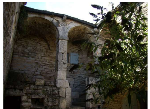
La ferme du Tensonnieu Photographie SDAP 2007
